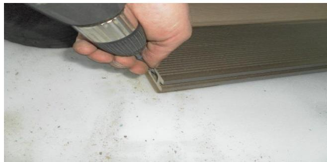
При дальнейшей укладке вставляются монтажные клеммы в боковой паз террасной доски в месте крепления к лаге (по всей длине доски таким образом, чтобы они плотно прилегали и не были перекошены). Затем необходимо вставить саморезы с потайной головкой в отверстия монтажных клемм и притянуть их к монтажной лаге до неподвижного состояния доски.
