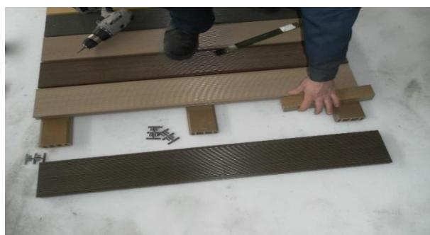
Повторить эти действия с каждой последующей доской, пока не будет установлена последняя доска. По окончанию укладки внутренний край последней доски крепиться при помощи клеммы, как и предыдущие доски.
