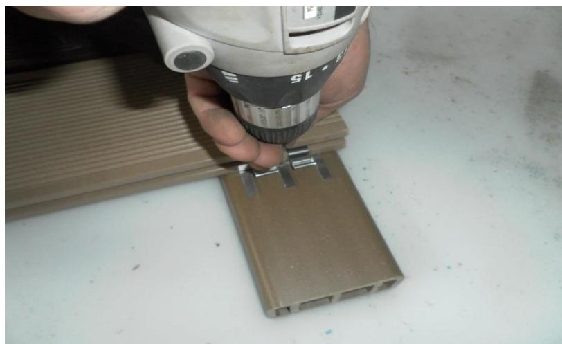
При начале укладки и в конце укладки необходимо произвести крепление первого профиля монтажной клеммой или ввинтить шуруп с потайной головкой или саморез в предварительно раззенкованное отверстие рядом с перемычкой профиля (рис.3). При этом необходимо следить за расположением доски. При необходимости начальный профиль может быть индивидуально подогнан по ширине.
